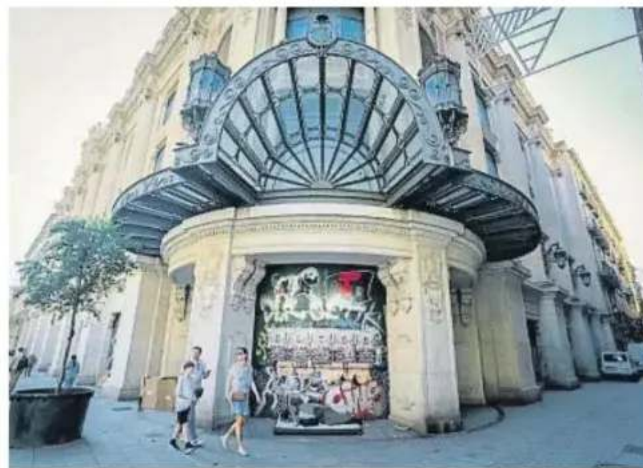
Esta es la imagen actual de la entrada principal del edificio
